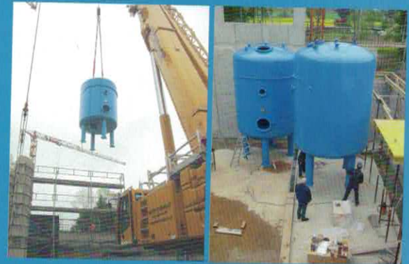
Mai 2017: Einbau der Kalkfilter und des Kalksilos
