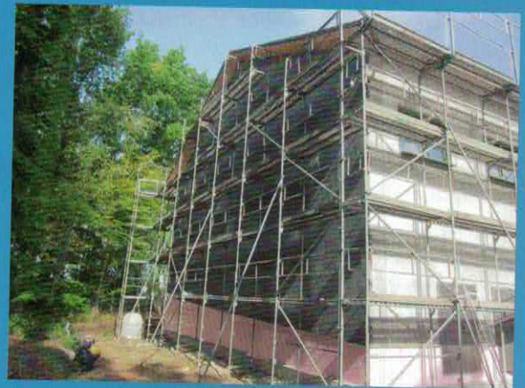
September 2017: letzte Gebäudeaußenarbeiten
