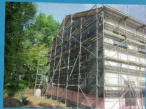
September 2017: letzte Gebäudeaußenarbeiten
