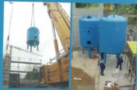
Mai 2017: Einbau der Kalkfilter und des Kalksilos
