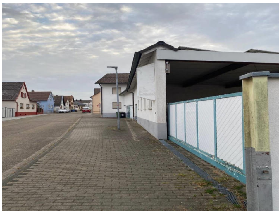
Vorhandene Bausubstanz im Kreuzungsbereich „Hindenburgstraße“ – „Obere Straße“
